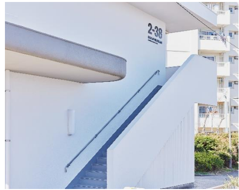
商店街施設棟の外壁
