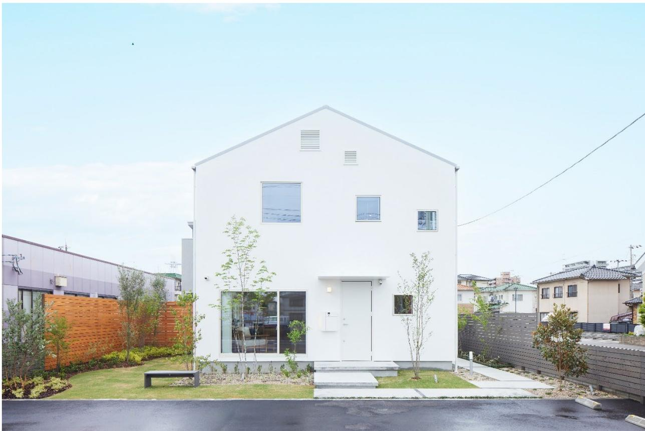
岡山南店「窓の家」モデルハウスは、高性能な住宅を実現するため、窓には「アルミ樹脂複合サッシ」と「トリプルガラス」を採用しています。外壁の断熱には外張り断熱と充填断熱を併せたダブル断熱を標準仕様としており、モデルハウスの断熱性能は、UA 値「0.38」、断熱等級 6 を実現、2030 年に全ての新築住宅に義務化が予定されている断熱等級 5 を大きく上回っております。また、無印良品の家ではすべての建物を「耐震等級 3」の耐震性を確保しており、採用している S E 構法は、強度が明確な「構造用集成材」の柱と梁を「S E 金物」で接合し、構造の耐久性を数値で証明する「構造計算」を可能にしています。無印良品の家では建設するすべての建物を、一棟ずつ個別に構造計算を実施しています。
