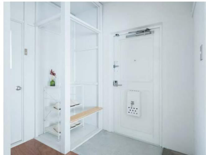
玄関脇の収納を撤去し、残した木枠にベンチを取付けました。靴を履く時などの腰かけとして使用できます。
